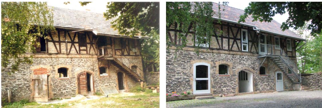
Alter Pferdestall, vor und nach der Renovierung
